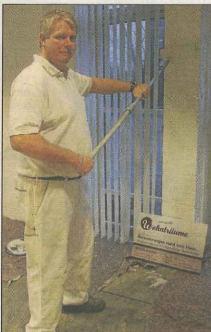
Olaf Schneider kümmert sich um alle Arbeiten rund ums Haus. Foto: cht
